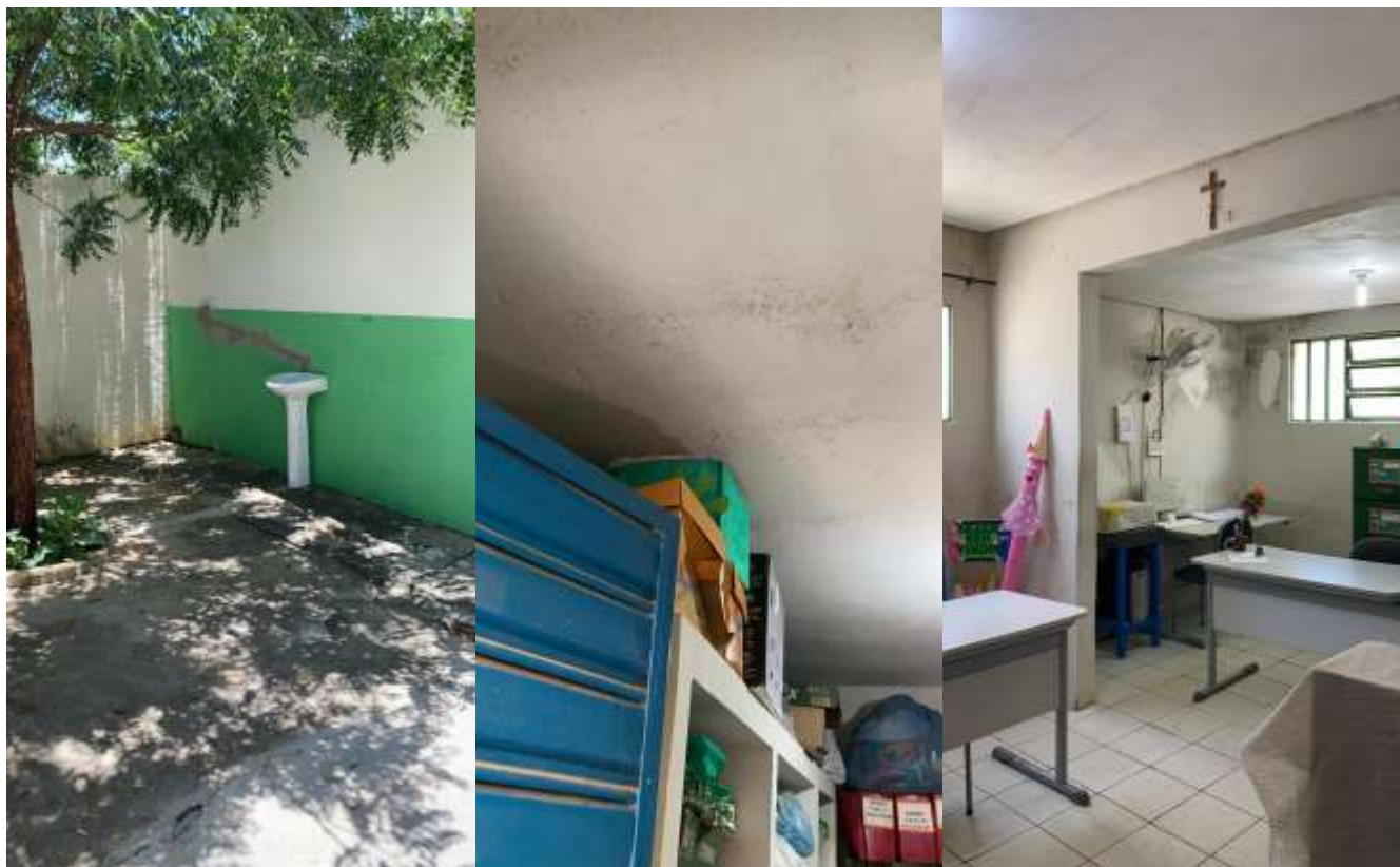
Figura 14 – Acesso a entrada principal, sala usada como biblioteca e sala da diretoria
