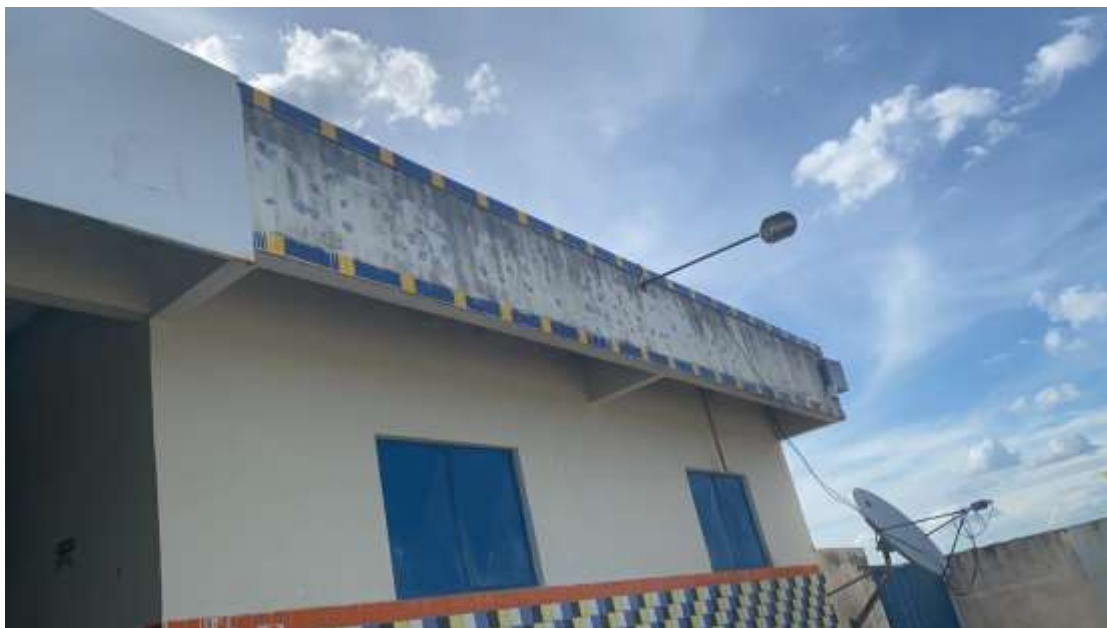
Figura 29 – Acesso a entrada principal
