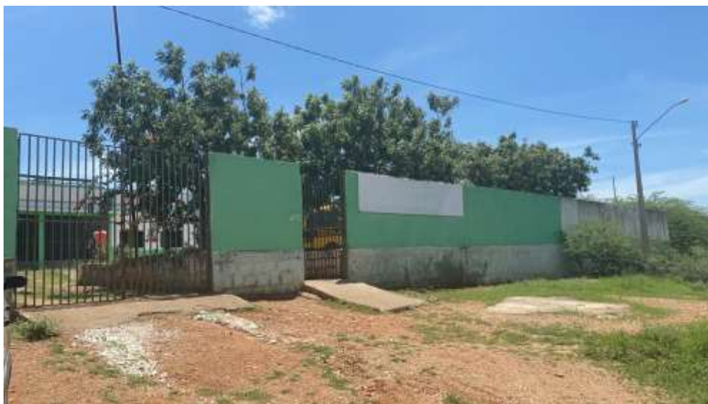
Figura 01 – Fachada atual em revestimento de argamassa
