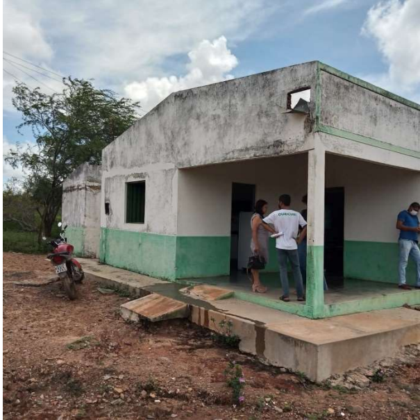
Foto 1 – Recuperação de fachada por meio de regulamentação da face mais pintura.
