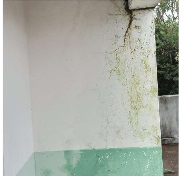
Foto 52 – Recuperação de estrutura por meio de reforço.
