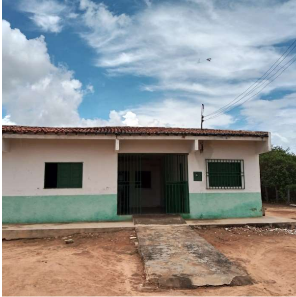
Foto 9 – a) Recuperação de fachada por meio de regulamentação da face mais pintura. b) pintura de portas e janelas. c) Demolição e construção de rampa de acordo com as normas vigente.
