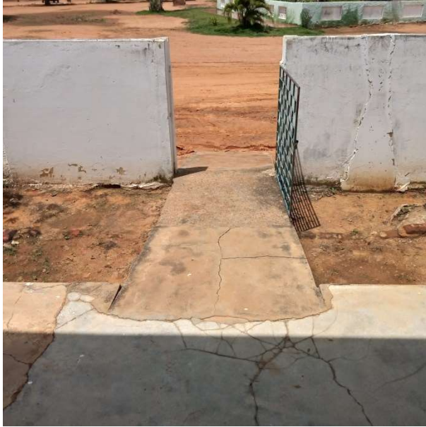
Foto 34 – Readequar rampa de entrada de acordo com parâmetros normativos.
