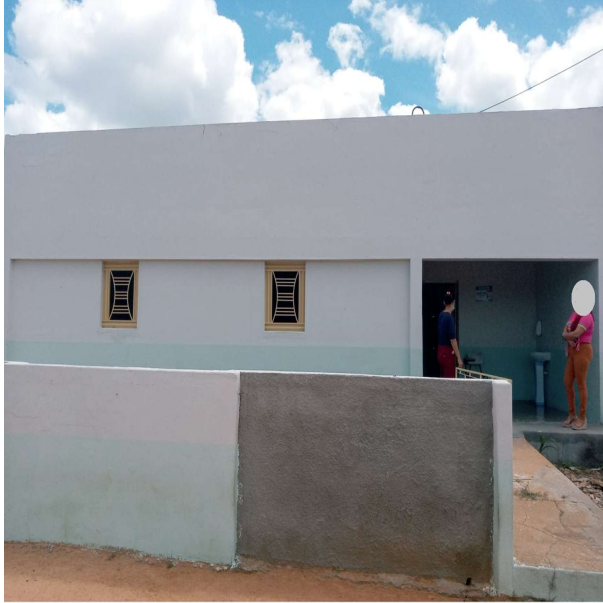
Foto 17 – a) pintura da fachada. b) pintura de portas e janelas.
