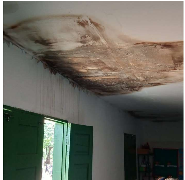
Foto 12 – Sala de aula: remoção de forro condenado para assentamento de outro.
