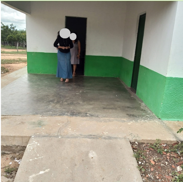
Foto 59 – Pátio: assentamento de revest. cerâmico no piso.
