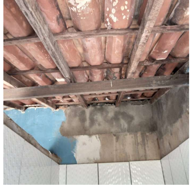
Foto 27 – Banheiros exist.: instalação de forno.
