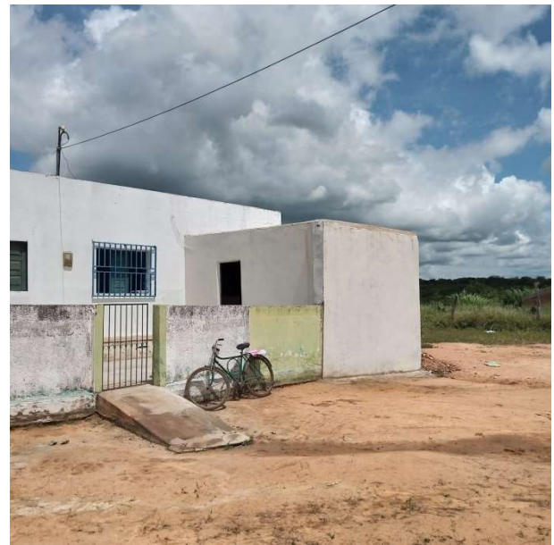
Foto 29 – Readequar rampa de entrada de acordo com parâmetros normativos.
