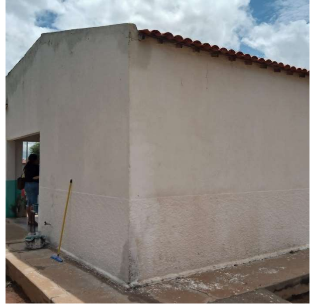
Foto 39 – a) pintura da fachada. b) pintura de portas e janelas.
