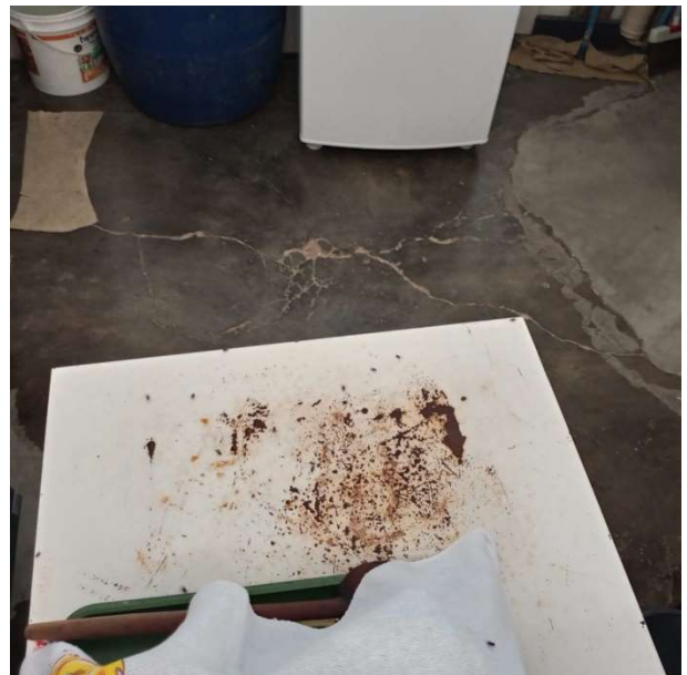
Foto 54 – Cozinha: assentamento de revest. cerâmico no piso e nas paredes.
