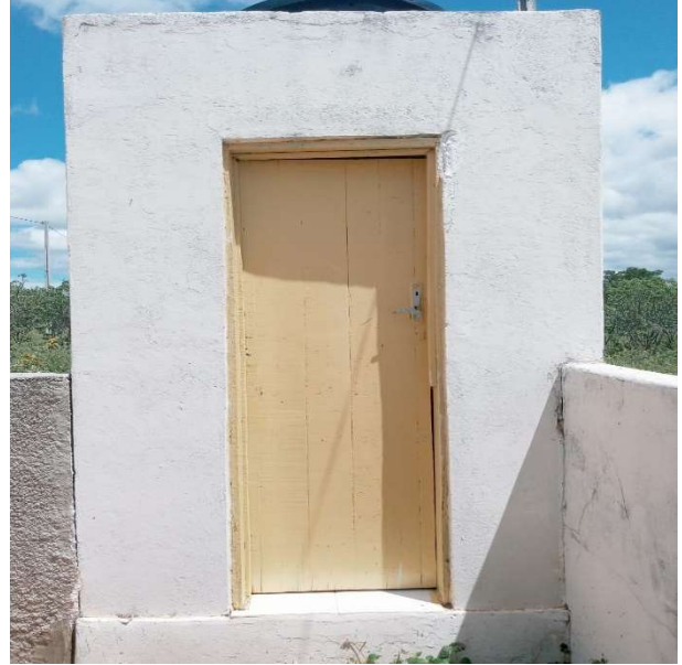
Foto 18 – banheiro existente. Construção de mais 03 (três) banheiros.
