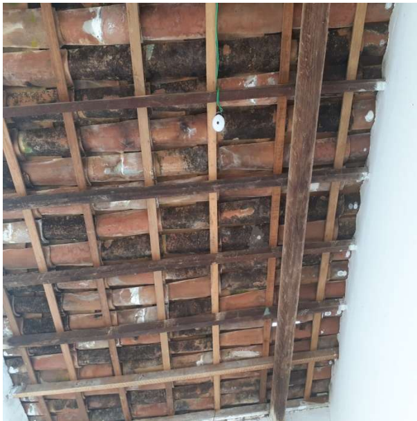
Foto 36 – Área externa: instalação de forro.
