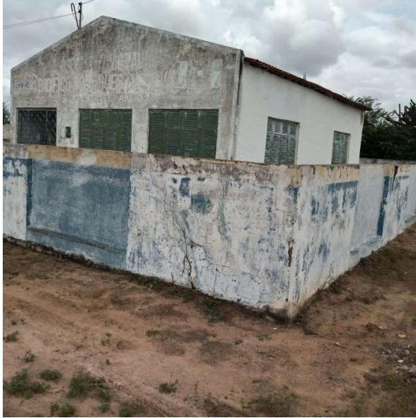
Foto 45 – a) pintura da fachada. b) pintura de portas e janelas.
