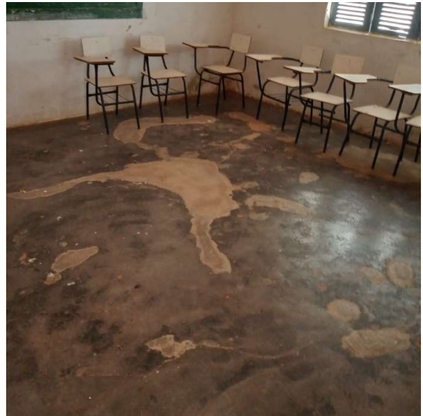
Foto 48 – Salas de aula: assentamento de revest. cerâmico.
