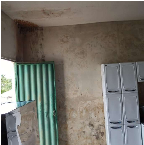
Foto 47 – Cozinha: assentamento de revest. cerâmico no piso e nas paredes.
