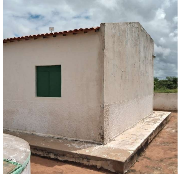
Foto 42 – Alargamento e readequação de calçada p/ promover acessibilidade para cadeirante (PCD).
