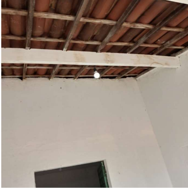
Foto 55 – Pátio: instalação de forro.
