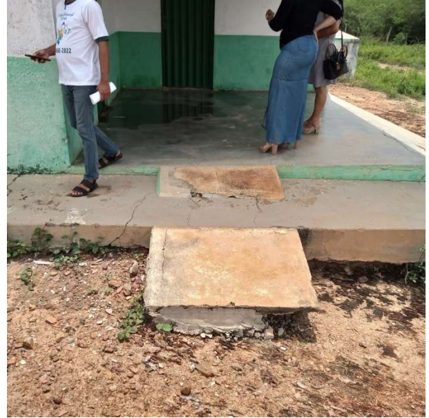
Foto 2 – a) construção de rampa adequada c/ a norma vigente; b) Alargamento da calçada de acordo com os parâmetros normativos.
