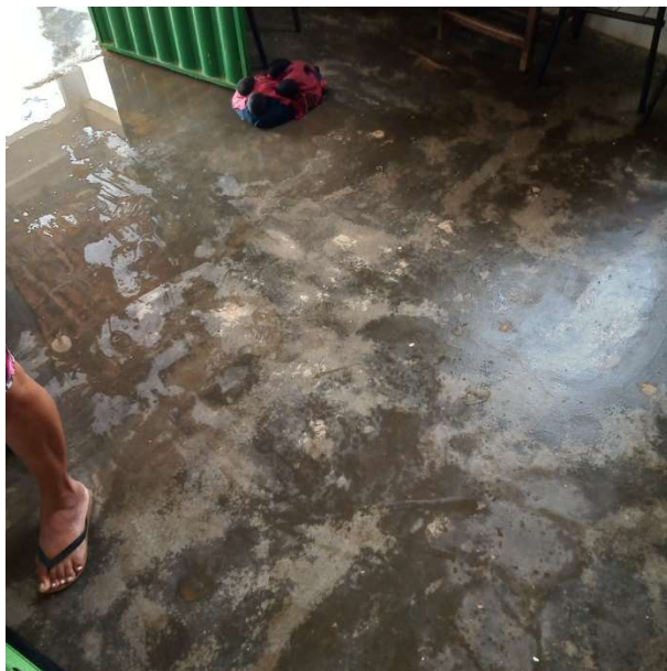
Foto 3 – Cantina: assentamento de revestimento cerâmico no piso e nas paredes.
