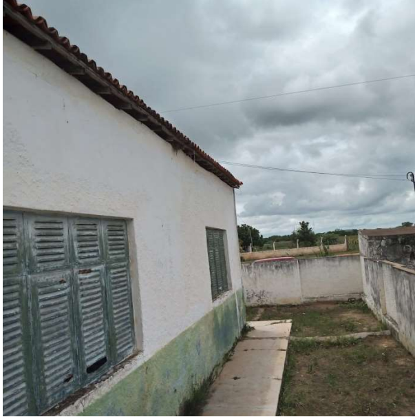
Foto 49 – a) pintura da fachada. b) pintura de portas e janelas.
