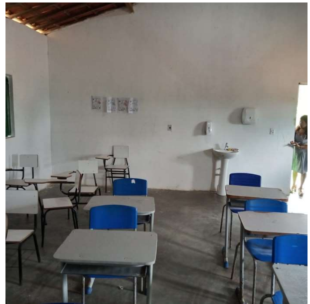
Foto 60 – Salas de aula: assentamento de revest. cerâmico.
