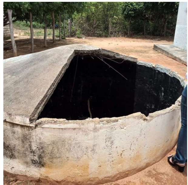
Foto 16 – Demolição e aterro de cisterna condenada.
