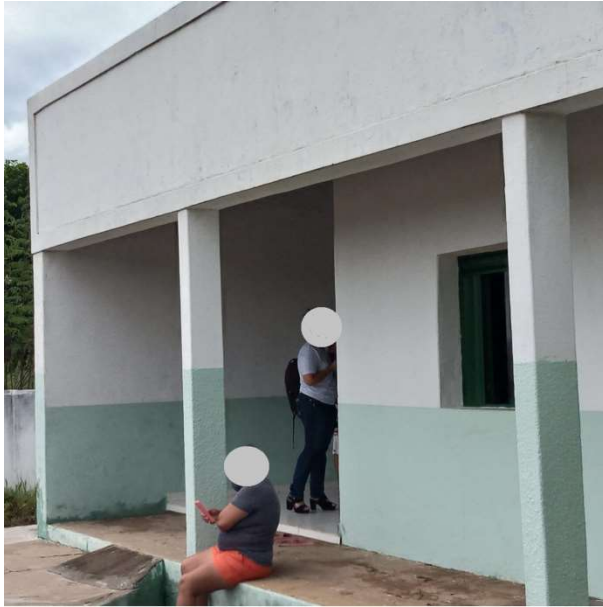
Foto 51 – a) pintura da fachada. b) pintura de portas e janelas.
