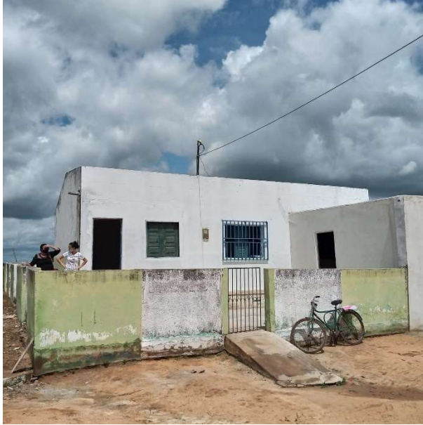
Foto 22 – a) pintura da fachada. b) pintura de portas e janelas.
