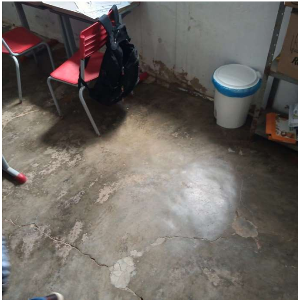
Foto 24 – Sala de aula: assentamento de piso cerâmico.
