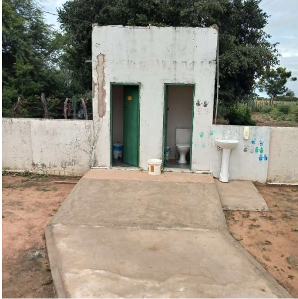
Foto 42 – Construção de mais 02 (dois) banheiros, sendo um para PCD.
