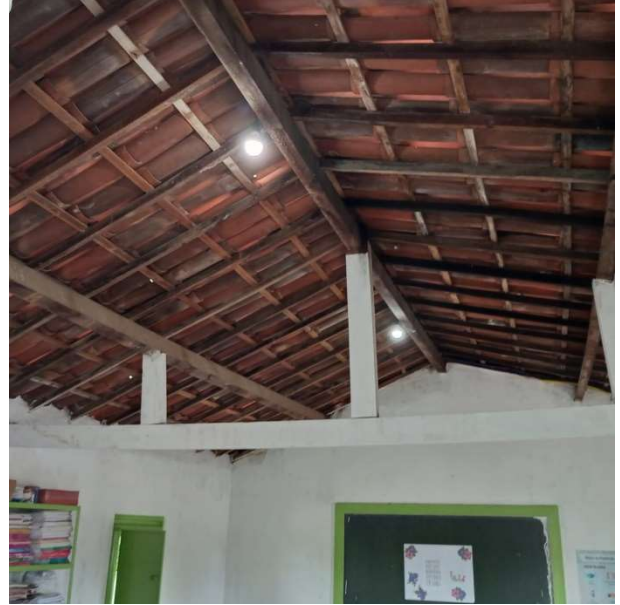
Foto 56 – Salas de aula: instalação de forro.
