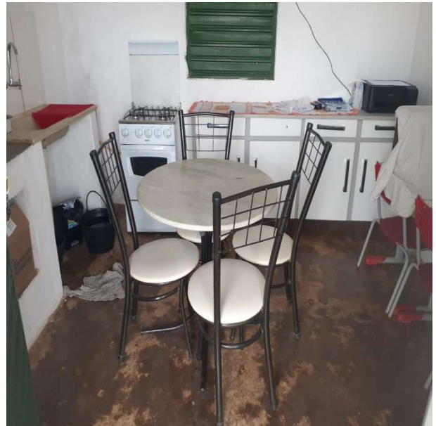
Foto 33 – Cozinha: assentamento de revest. cerâmico.
