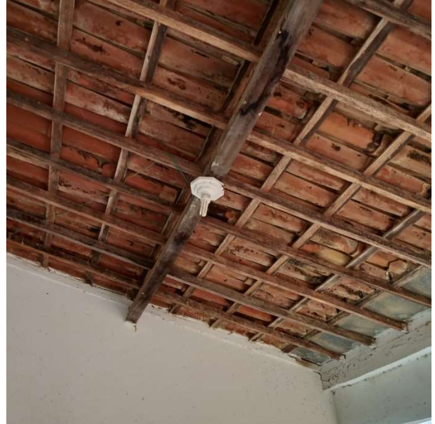
Foto 6 – Pátio: assentamento de forro de gesso.
