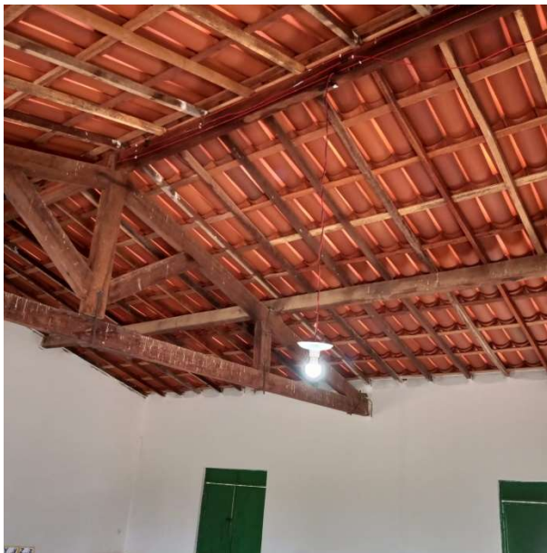
Foto 43 – Sala de aula: instalação de forro.
