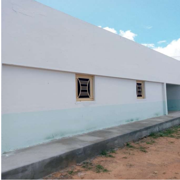
Foto 20 – Alargamento e regularização da calçada de acordo com as normas vigente de acessibilidade.
