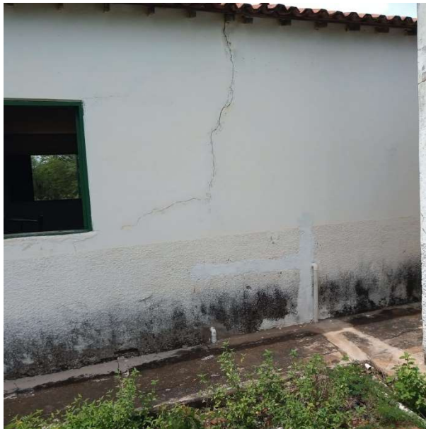
Foto 7 – Fachada: reforço de alvenaria por meio de tela.
