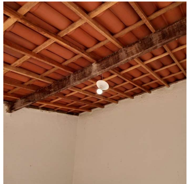
Foto 44 – Pátio: instalação de forro.
