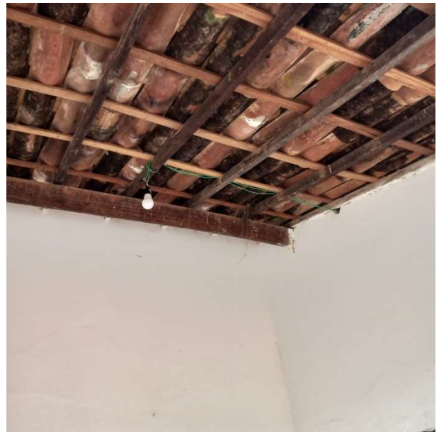
Foto 37 – Pátio: instalação de forro.
