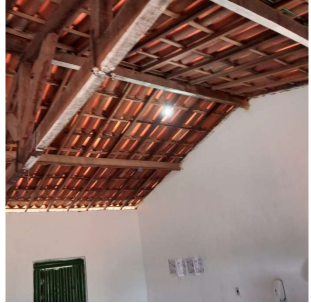
Foto 62 – Salas de aula e pátio: instalação de forro.
