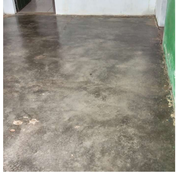
Foto 14 – Pátio: assentamento de revest. cerâmico.
