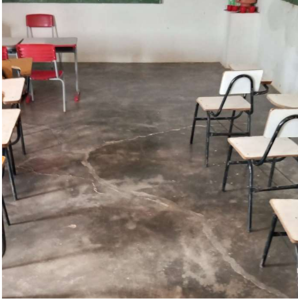
Foto 13 – Sala de aula: assentamento de revestimento cerâmico.
