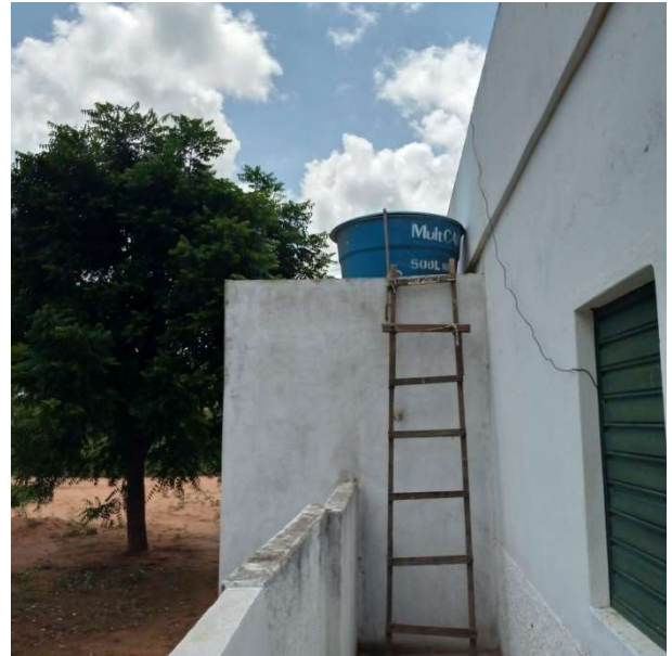
Foto 35 – Construção de mais 03 (três) banheiros, sendo um para PCD.
