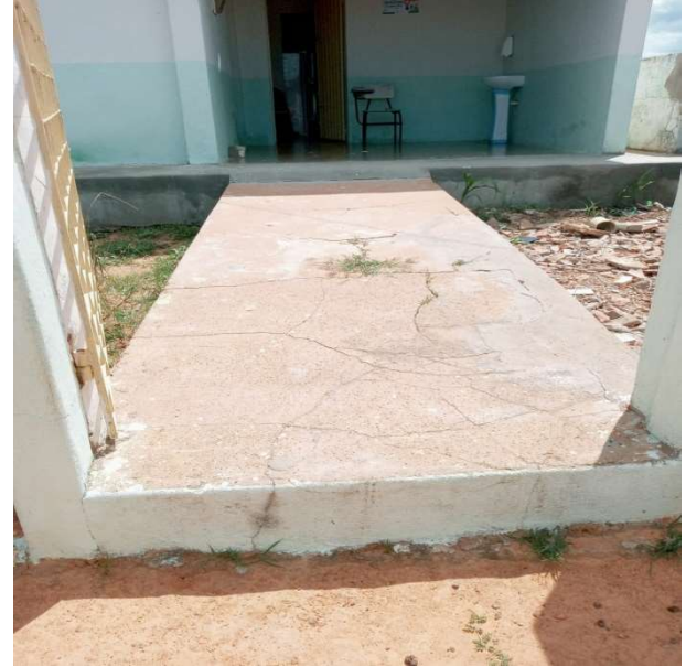
Foto 21 – construção de rampa de acordo com parâmetros técnicos
