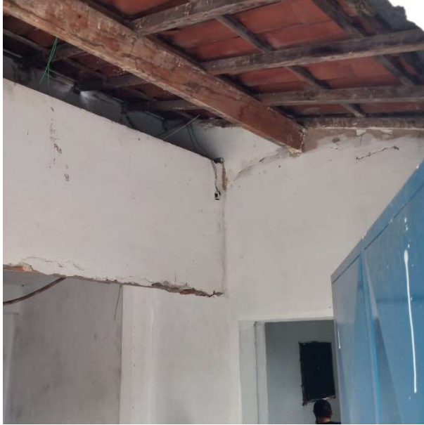
Foto 26 – Pátio int.: instalação de forno.
