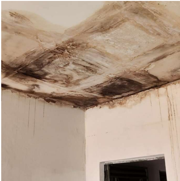
Foto 11 – Pátio: remoção de forro condenado para assentamento de outro.
