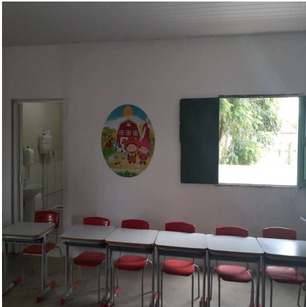
Foto 32 – Sala de aula: assentamento de revest. cerâmico.
