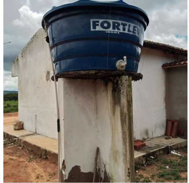
Foto 10 – Demolição de estrutura. Realocação da caixa d'água em cima da laje dos novos banheiros.
