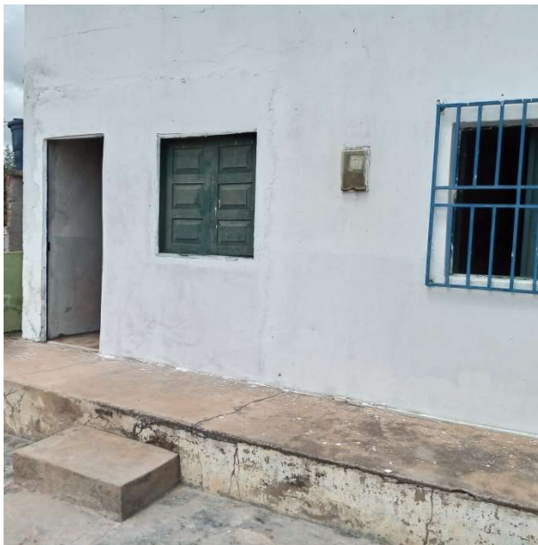
Foto 28 – Construção de rampa, alargamento de calçada para promover acessibilidade aos banheiros, mais construção de banheiro adaptado para cadeirantes.
