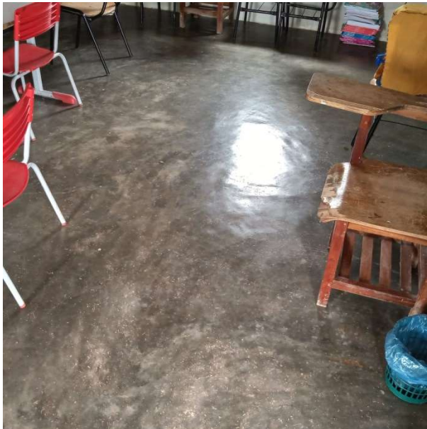
Foto 40 – Sala de aula: assentamento de revest. cerâmico.
