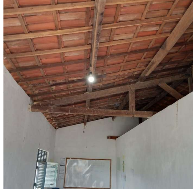
Foto 50 – Salas de aula: instalação de forro.
