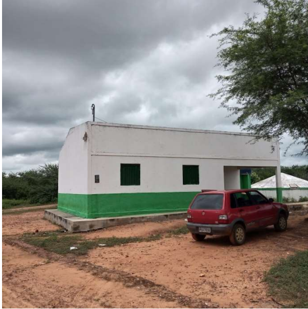
Foto 57 – a) pintura da fachada. b) pintura de portas e janelas.
