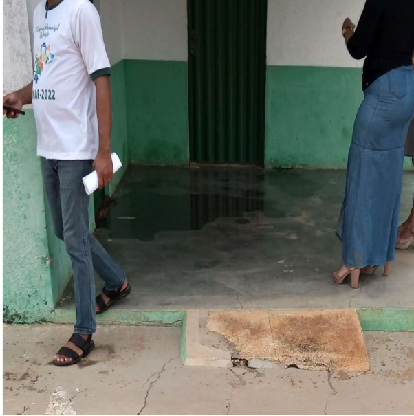
Foto 5 – Pátio: assentamento de revestimento cerâmico.
